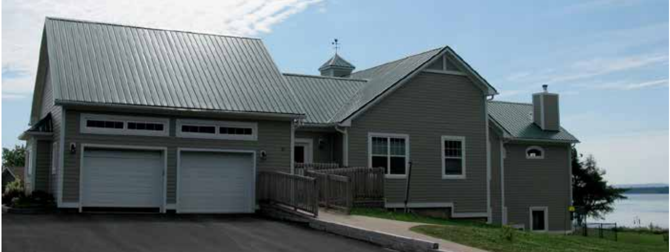
Photo : Le trottoir mène jusqu'à une porte latérale accessible et très utilisée
